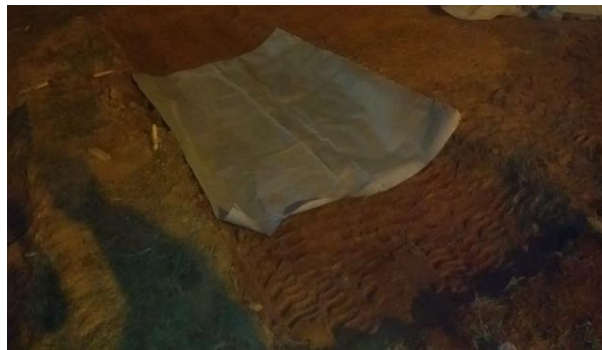
Figura 3.22: Colocação do geotêxtil tecido entre a camada de subleito e a sub-base.
