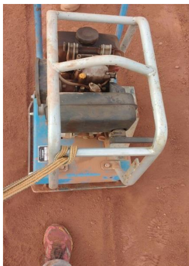
Figura 3.19: Compactação da camada do subleito com uso da placa vibratória.
