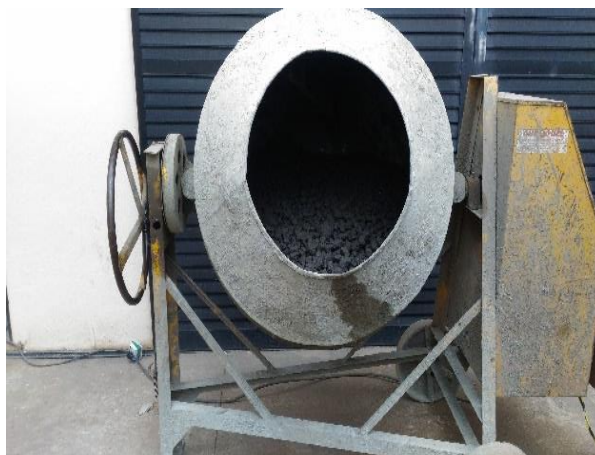
Figura 3.23: Homogenização da escória aplicada na sub-base com auxílio da betoneira.
