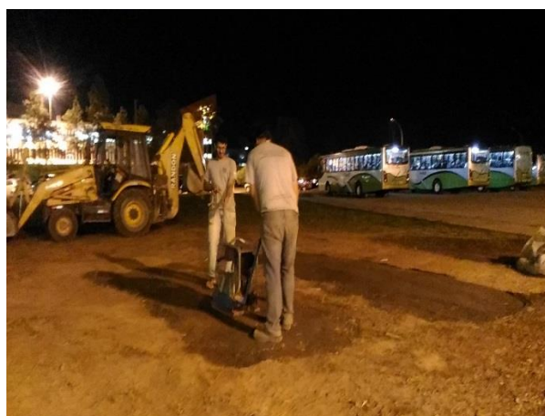
Figura 3.24: Compactação da sub-base com uso da placa vibratória.
